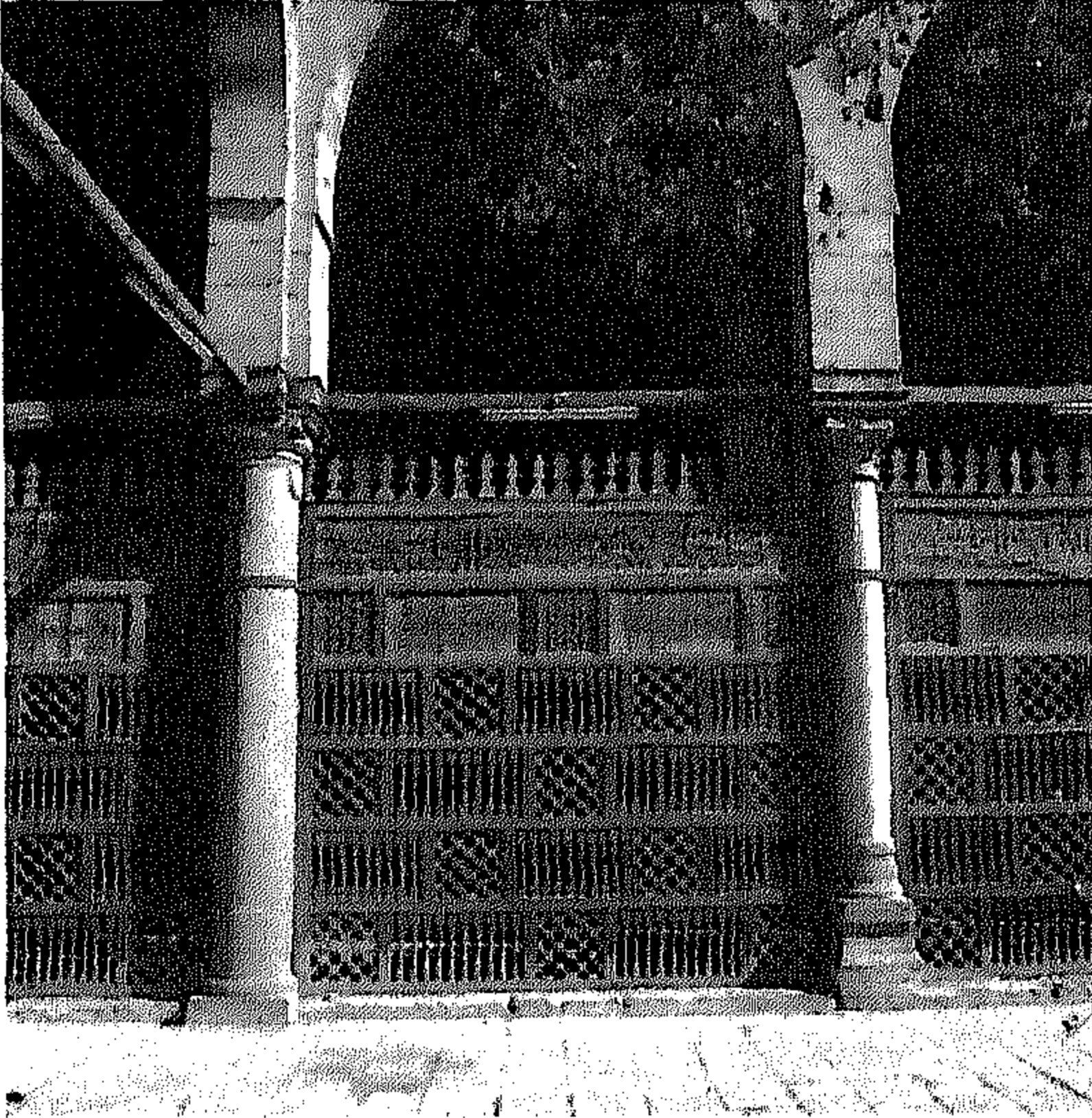
مسجد الطنبغا المارداني الحجاب الخشبي - الذي يفصل بيت الصلاة عن الصحن - القاهرة.
